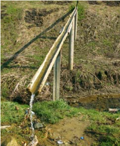
Джерело, обладнане дерев'яним «міні-віадуком»
